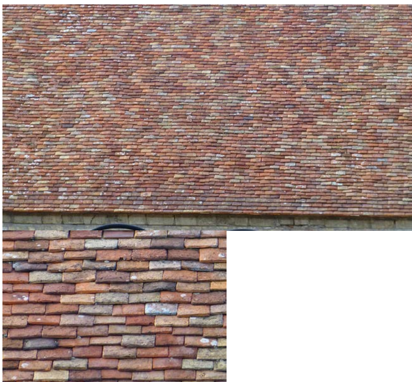
La restauration des couvertures en tuiles doit s'effectuer en tuiles plates légèrement bombées afin de donner un aspect irrégulier.
