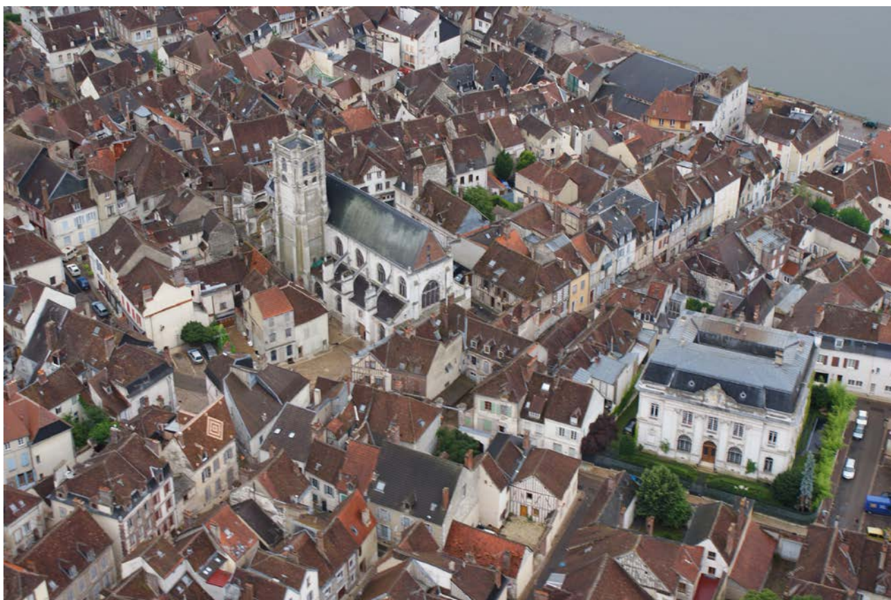
Les couvertures en tuiles plates sont encore dominantes dans le quartier « médiéval ».
