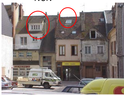
Altération d'aspect des toitures
