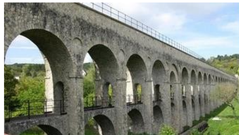
L'Aqueduc de la Vanne (XIX ème Siècle)
