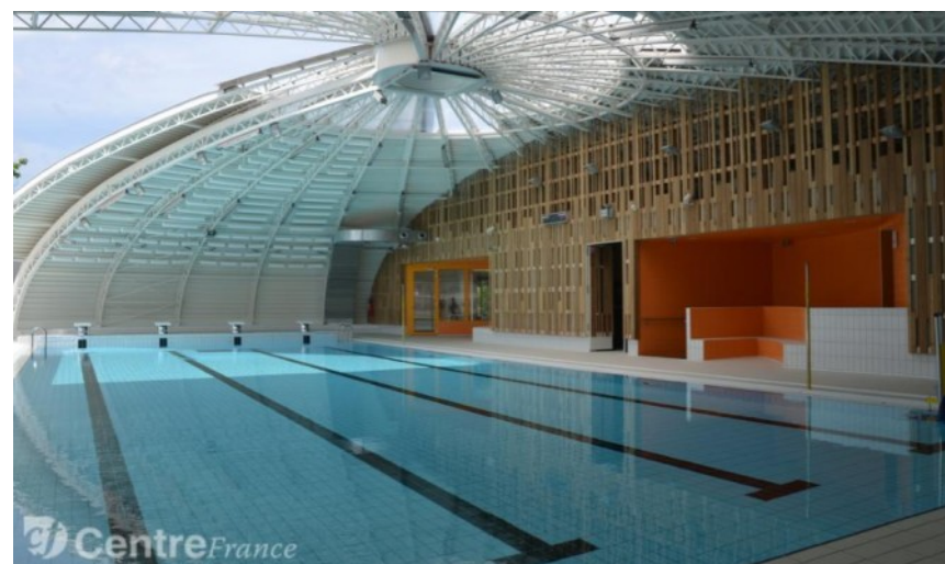
Piscine Tournesol à Sens – Source : Yonne
