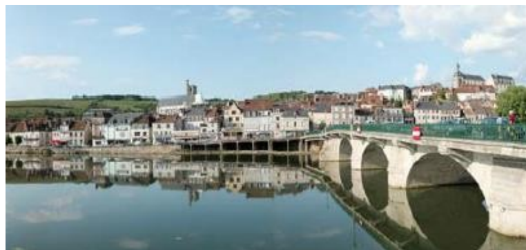
Pont à Joigny- Source : Ville de Joigny
