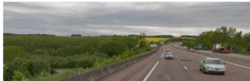
Franchissement par l'A6 de la Vallée du Vrin, un point de rupture dans la Trame Verte et Bleue
